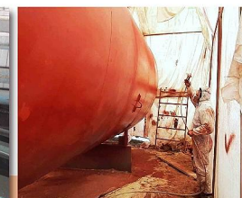
Окраска металлических конструкций
